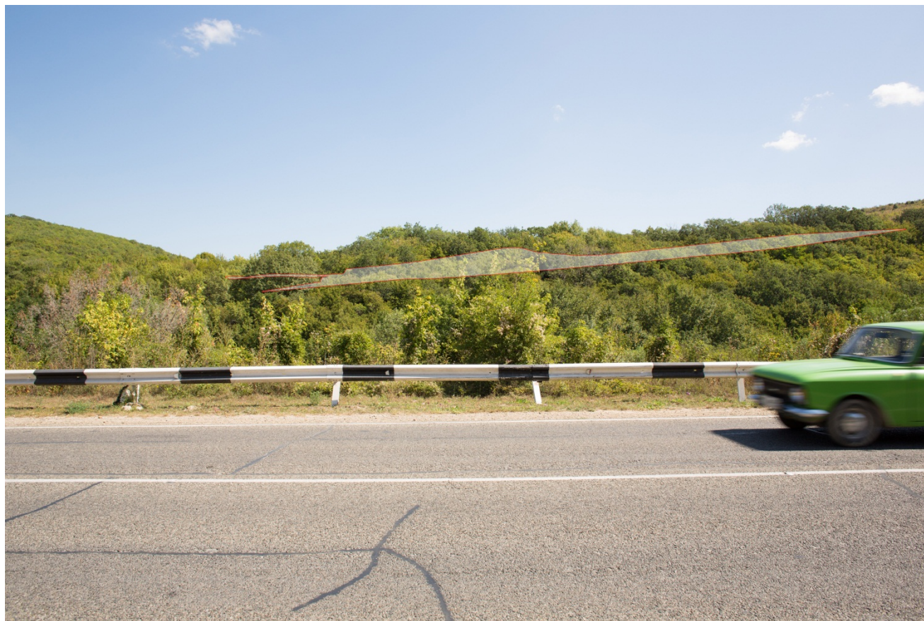
Фотографии За.1 Точка обзора За: от Варваровка-Суккойской дороги (Путешественники) – Фаза строительных и пуско-наладочных работ
