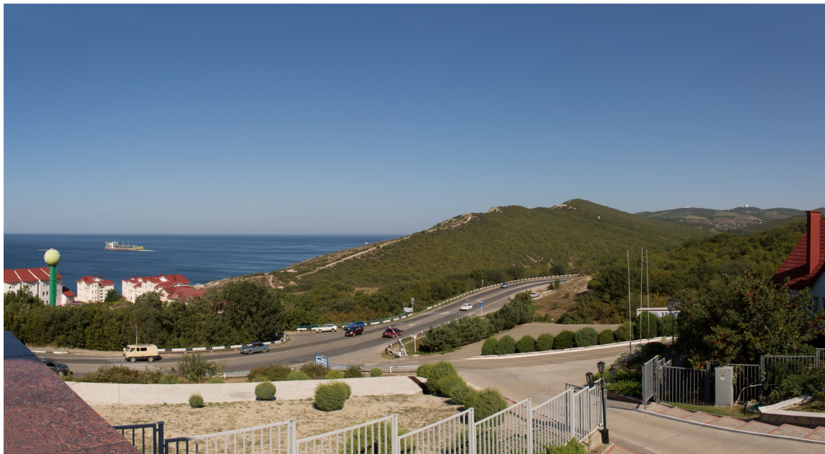
Фотографии 1b.1 Точка обзора 1b: от курортного комплекса Дон (Отдыхающие посетители) – Фаза строительных и пуско-наладочных работ
