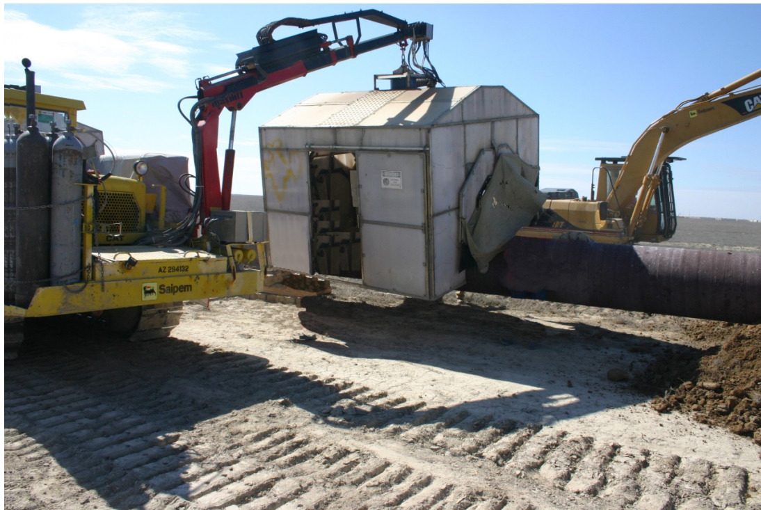
Рисунок 5.16 Нанесение покрытия монтажного соединения
