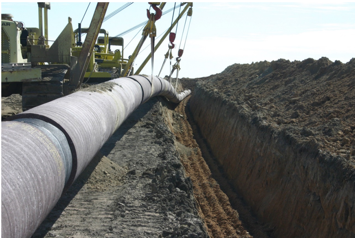
Рисунок 5.17 Укладка трубы в траншею
