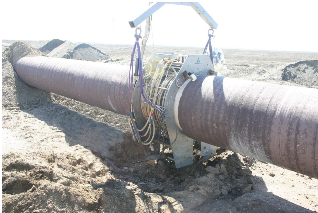
Рисунок 5.16 Нанесение покрытия монтажного соединения
