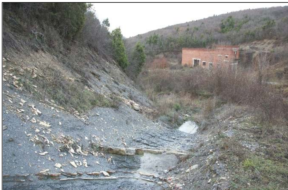
Рисунок 5.1-3 Общий вид долины правого притока р. Сукко на участке перехода
