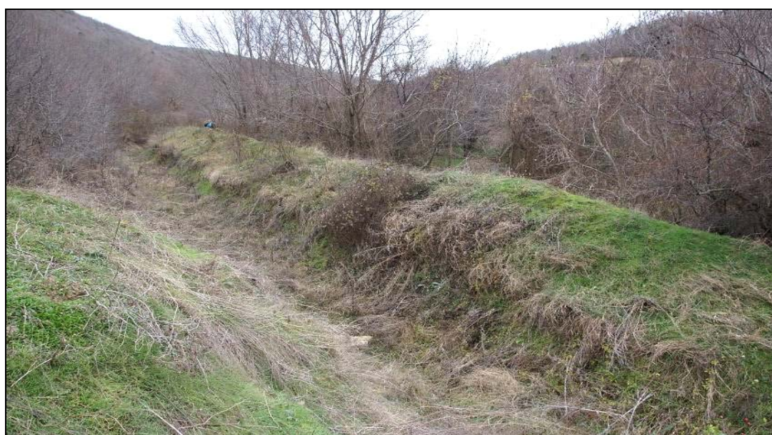
Рисунок 4.1-4 Искусственный водоотводный канал глубиной до 2,0-3,0 м вдоль левого берега основного русла р. Шингарь
