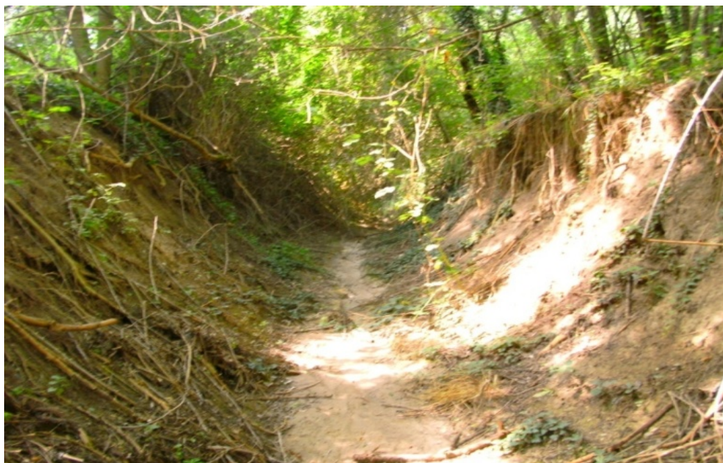
Рисунок 4.1-7 Эрозия русла временного водотока в Графовой щели
