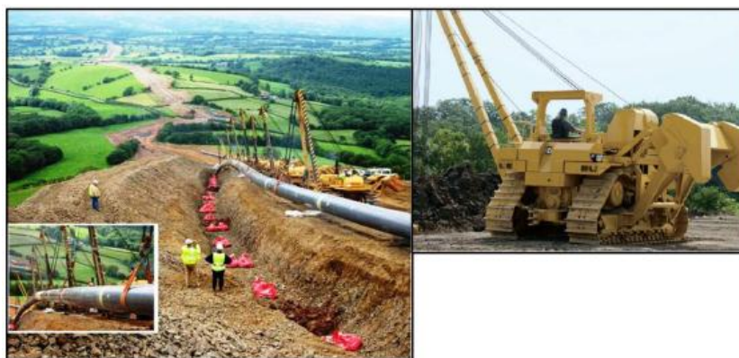
Рисунок 1.4-4 Типичная трубоукладочная установка
