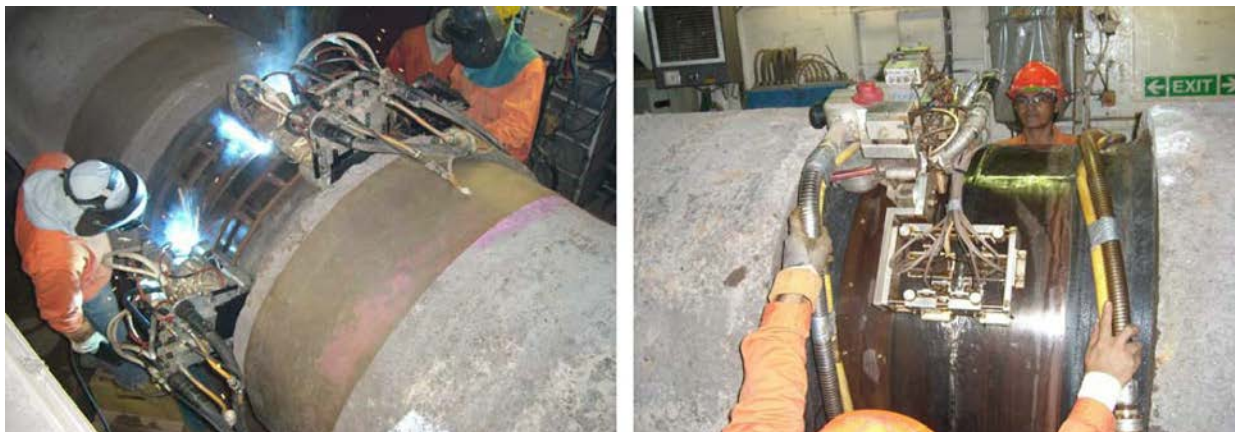
Рисунок 1.4-21 Сварка (слева) и автоматическое ультразвуковое тестирование (справа) монтажного стыка
